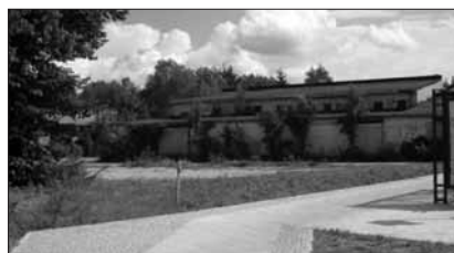
Blick auf das Baugrundstück aus nördlicher Richtung
